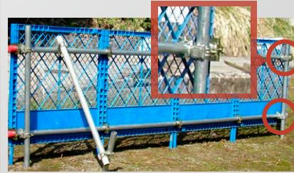
最後にV型（端部用）を反対側の一番端に取り付けフェンスを固定し完了です。
