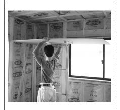
④ボードを左右のサポートに載せ ます。途中で落下しないよう十 分にバランスをとってください。
